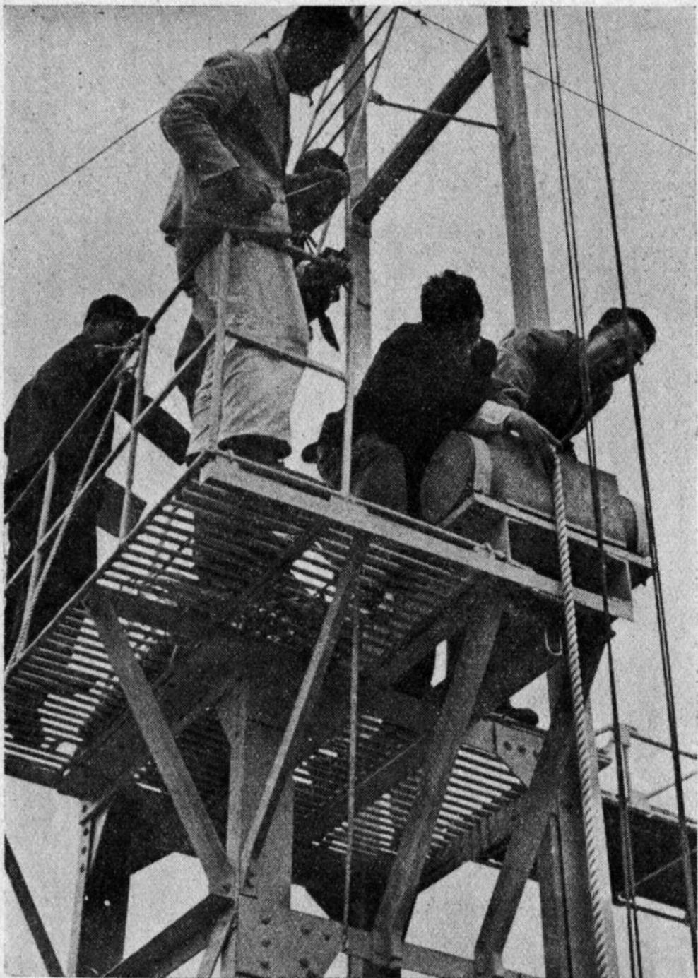
・24 m/m マニラザイル破損試験損傷調査（昭和30年4月29日）・
