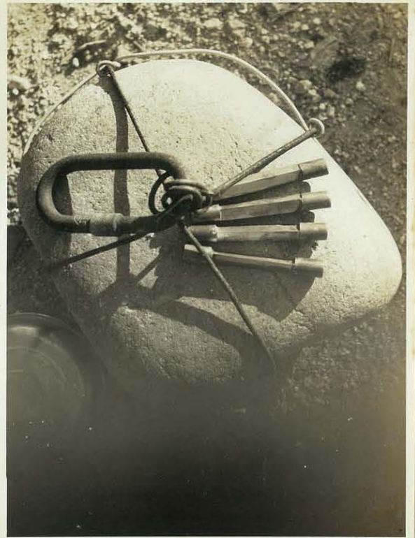
テストに用いた 15.5 Kgr の石, なお石 上に乗っているのは テストに用いた 種々の角度のエッジ とより 120°, 90°, 60°, 30°
